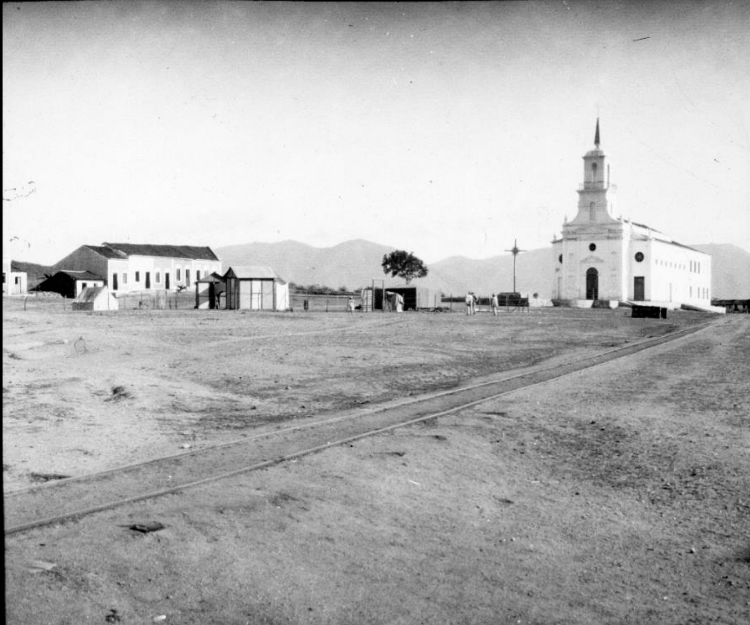
Equipamentos montados na praça do Patrocínio com a igreja Nossa Senhora do Patrocínio ao fundo
